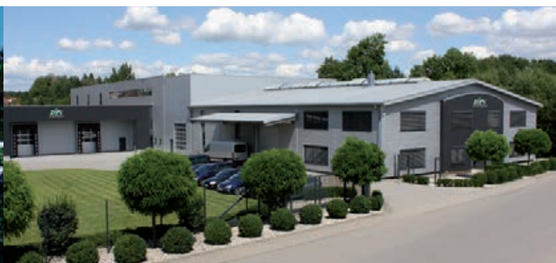
Triplement de la surface de l'exploitation de DPV à Eppingen, Allemagne
